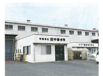
田中製作所の工場と事務所
